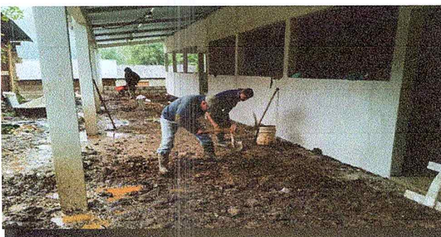
Foto 5: Mejoramiento de losa de patio (torta de concreto) tanto para corredor como aulas y baños.
