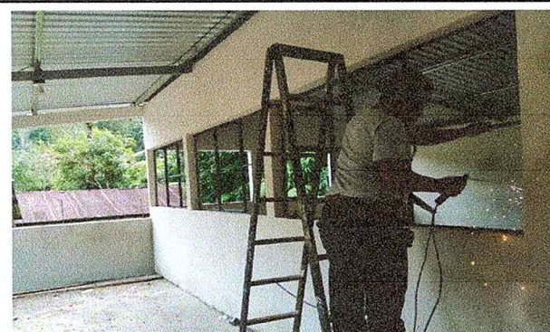
Foto 4: Instalación de ventanales de metal con su respectivo vidrio transparente.
