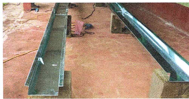
Foto 6: Mejoramiento de canales de metal para mejor captación de agua pluvial.
