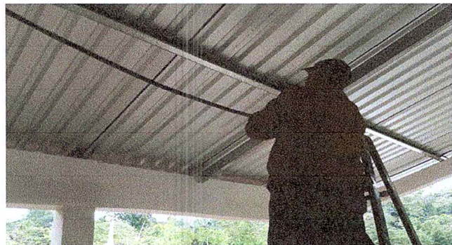
Foto 7: Mejoramiento de sistema eléctrico sustituyendo los cables inservibles y demás suministros eléctricos por nueva instalación.
